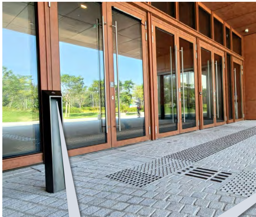
正门内外皆有按钮，方便访客使用自动门出入
