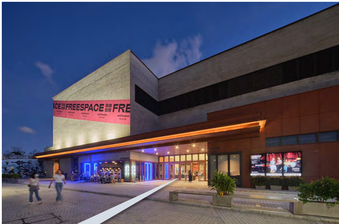
地下正门入口
